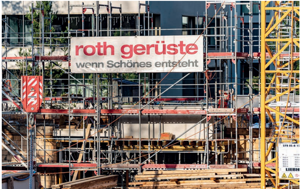
Roth Gerüste auf der Seewarte-Baustelle der Wohnüberbauung «Park Schönbühl», Zürich
