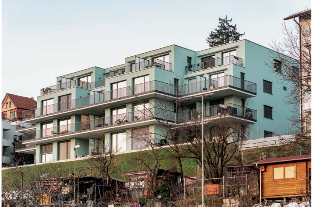
Erneuerungsbau Bauherrenstrasse, Zürich
